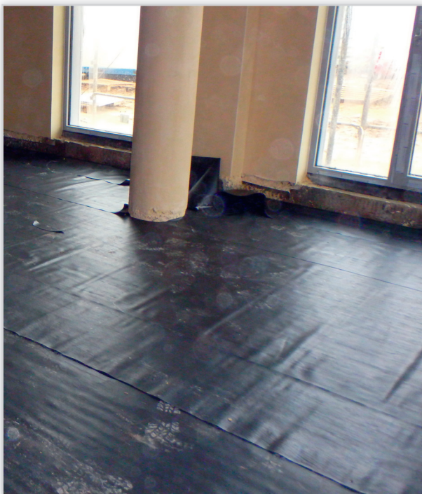
Folia hydroizolacyjna Izowinyl. Izolacja posadzki.
