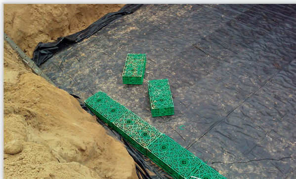
Folia hydroizolacyjna Izowinyl. Izolacja podziemnego zbiornika retencyjnego na wodę deszczową wypełnionego koszami Stormcell, Nidaplast lub innymi.
